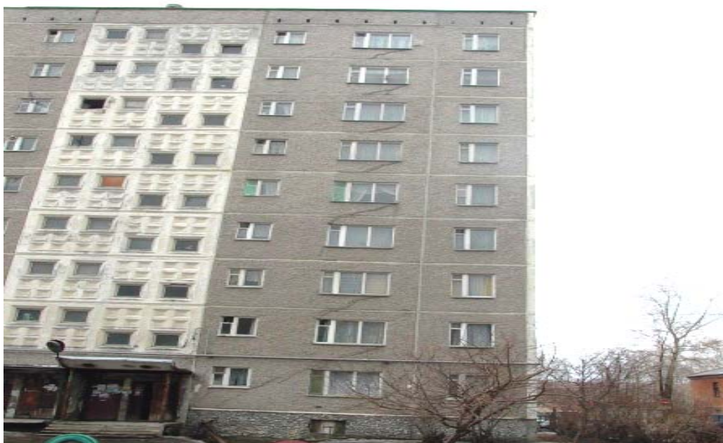
Рисунок 7 – Аварийный жилой дом по ул. Мусоргского, 6 в Екатеринбурге
