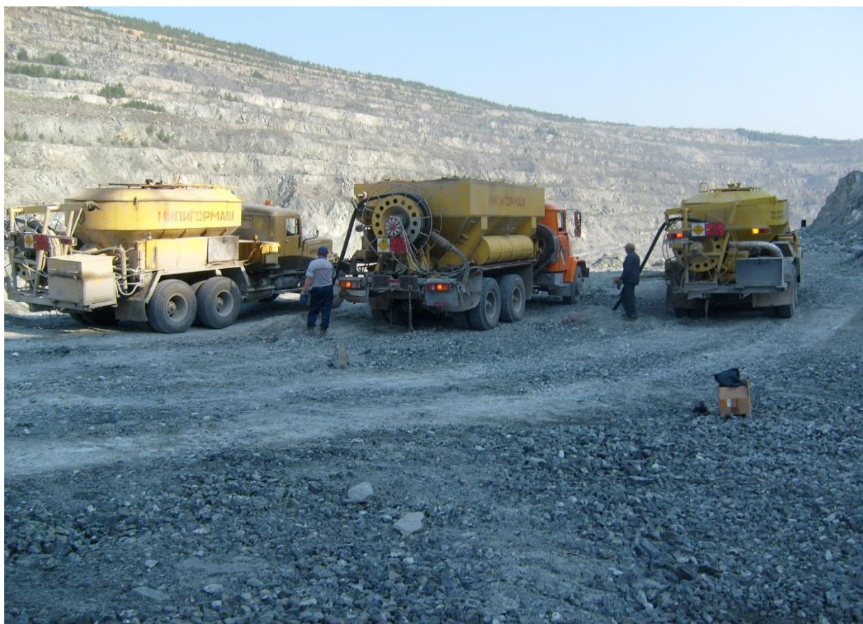
Рисунок 1.6 – Заряжание скважин порэмитом 1А СЗМ МЗВ-8, МЗВ-10 и СЗМ-8 на локальном блоке Центрального карьера Рудоправления ПАО «Ураласбест»
