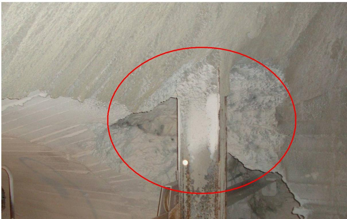
Рисунок 3.4 – Разрушение сопряжений в виде вывалов кусков крепи
