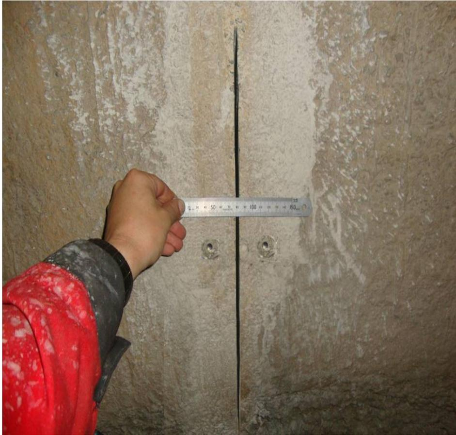
Рисунок 3.11 – Разгрузочная щель, выполненная в крепи ствола при помощи бензореза
