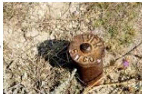
Рисунок 4.6 – Конструкция репера опорной сети
